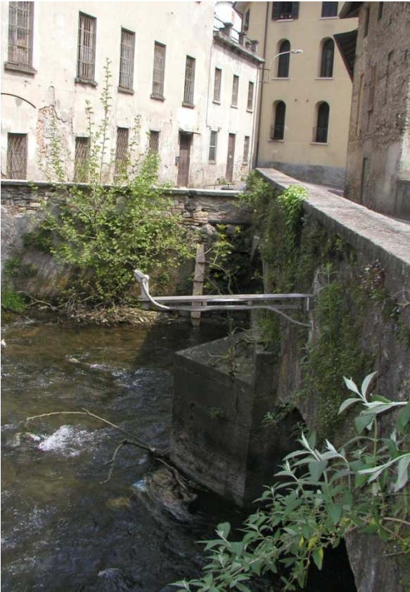
Figg. 8.43-8.44: le centraline di Merone (loc. Maglio, a sn)) e di Cologno Monzese (ponte di S.Maurizio, sotto)
